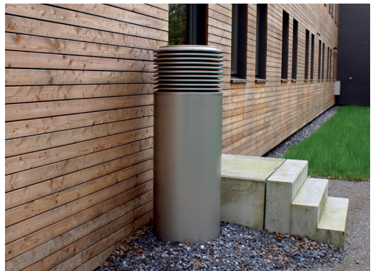
Ansaugöffnung für mechanische Zuluftanlage.
