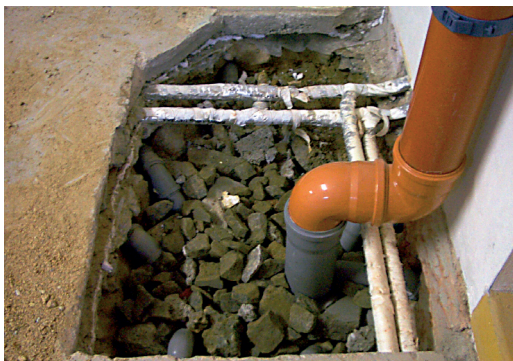
Punktueller Absaugung (Radonbrunnen) – Aushub eines Schachtes.
