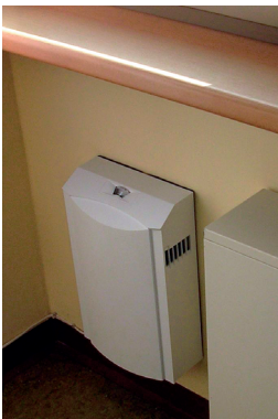
Kontrollierte Frischluftzufuhr erzeugt leichten Überdruck im Raum/Gebäude (Darstellung innen und außen).
