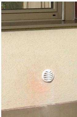
Kontrollierte Frischluftzufuhr erzeugt leichten Überdruck im Raum/Gebäude (Darstellung innen und außen).
