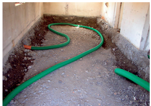
Erneuerung des Fußbodenaufbaues: Einbau einer Radondrainage.
