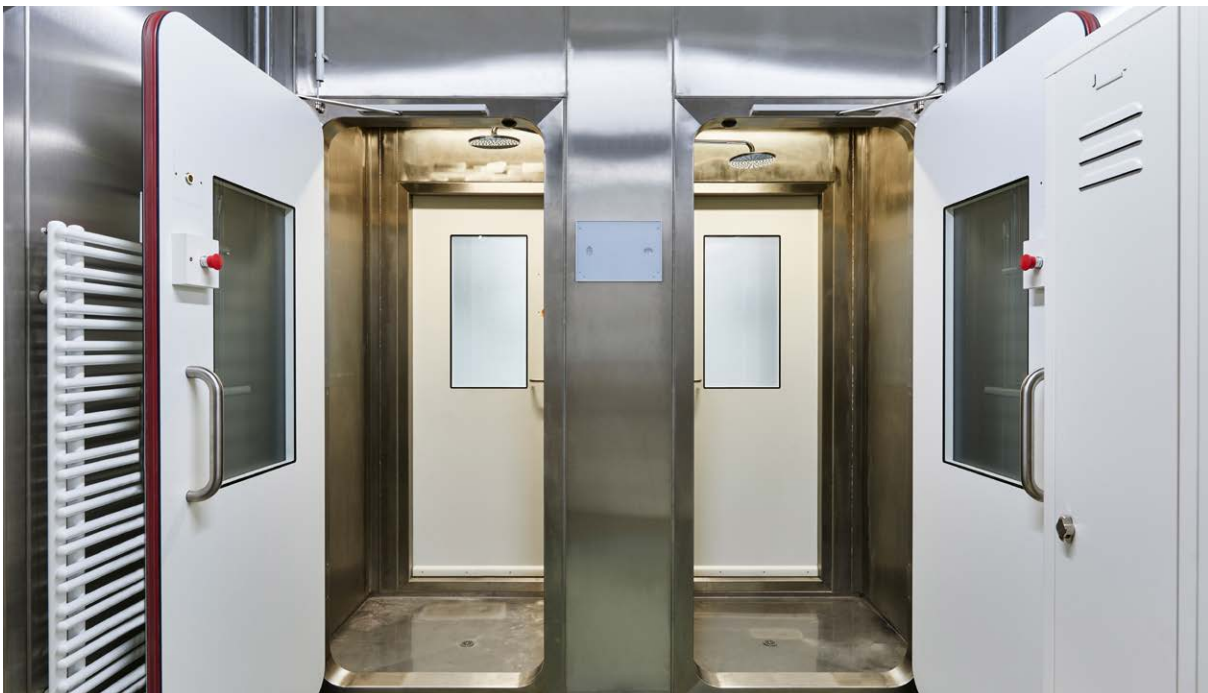
Abbildung 2: Eingang ins Labor über die Personenschleuse
